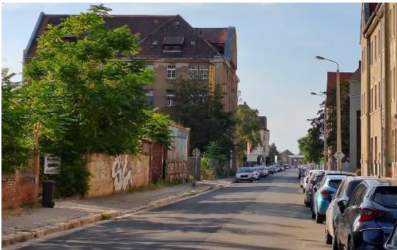
wenig gepflegt, Nachbargebäude überwiegend unsaniert
