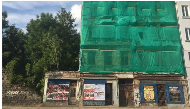
ungepflegt, fast ausschließlich unsanierte bzw. verfallene Gebäude
