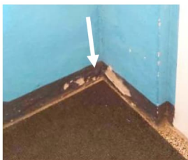
eher gepflegt, zum Teil er- neuerungsbedürftig Eingangsbereich
